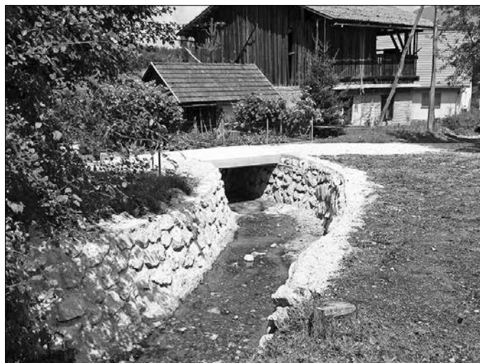
Nov betonski most preko Mostnega grabna v kraju Potok je zamenjal prejšnjega lesenega, ki je bil dotrajan.
