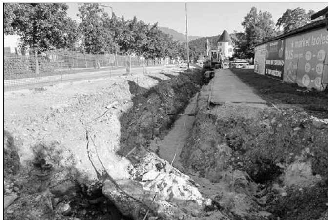
Zamenjava vodovoda v sklopu ureditve regionalne ceste R3-697/5514
